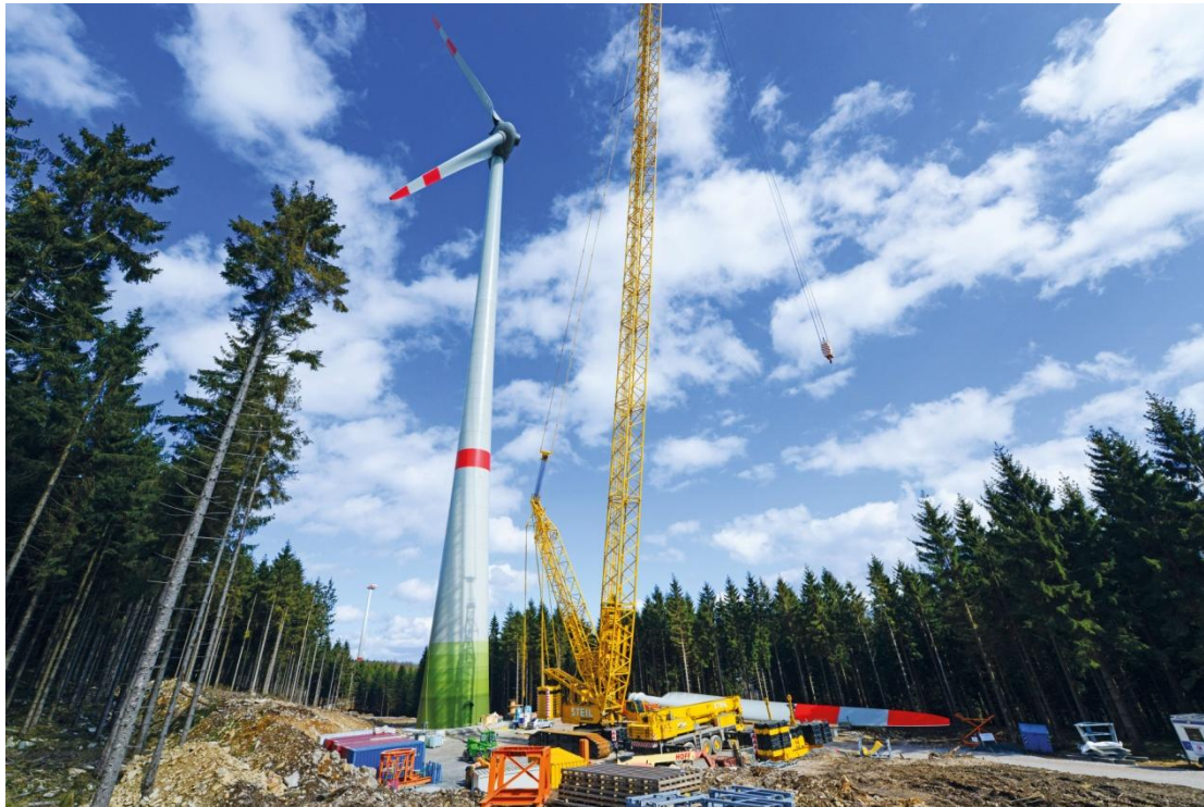
Windkraftbaustelle im Wald. Foto: Harry Neumann
